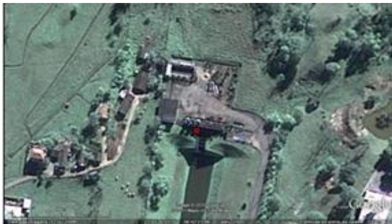
Figura 2 – Captação do Rio Cubatão
