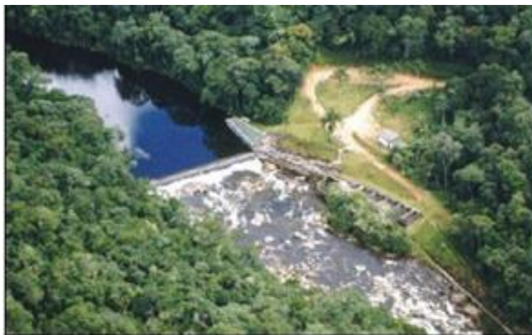
Figura 1 – Captação do Rio Pilões
